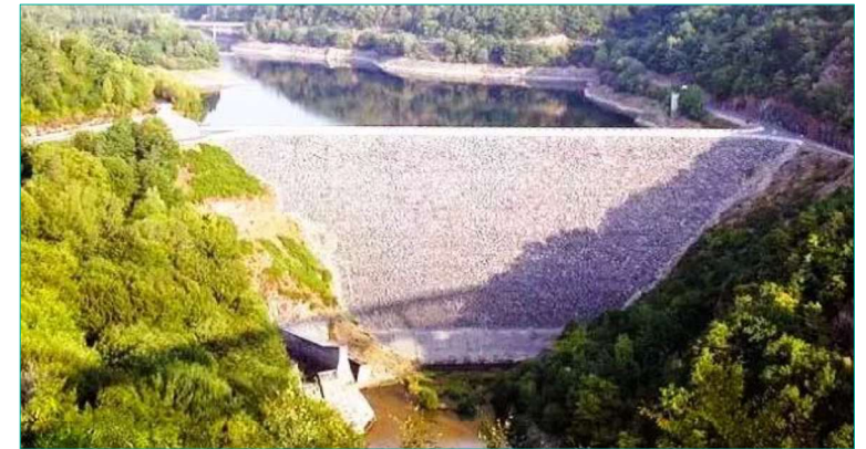
Barrage des Fades (risque inondation) - ©Lac des Fades Auvergne
